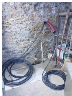
Câbles U1000 RO2V 4x25 2 Cuivre et multiphases en attente dans le sous-sol
