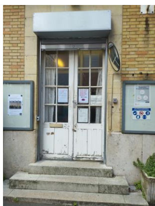
Remplacement rideau métallique Porte d'entrée loge
