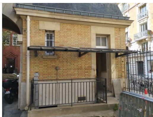
Remplacement des vitres de l'auvent avec réfection de la peinture des structures métalliques Remplacement du hublot par un hublot à Leds IP65
