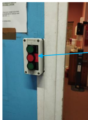
Commande actuelle d'ouverture et de fermeture des barrières
