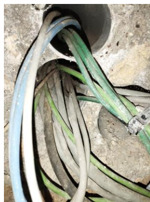
Câbles catégorie 5 à remplacer
