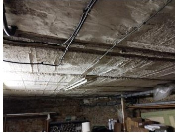
Retrait des installations électriques du sous-sol
