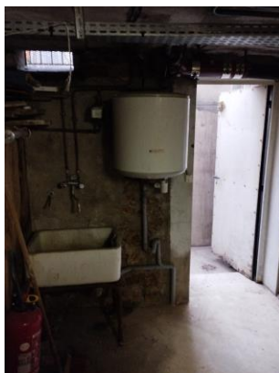
Retrait de l'évier et du ballon d'eau chaude, remplacement à l'identique
